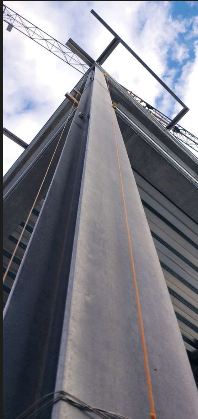
Strutture in acciaio
