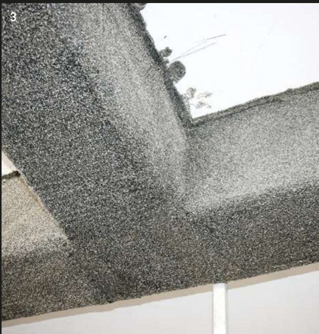
1. Isolatori sismico posizionamento, 2. Beton plaquè, 3. Rinforzi in FRP su travi, 4. Controventi dissipativi - Particolare
