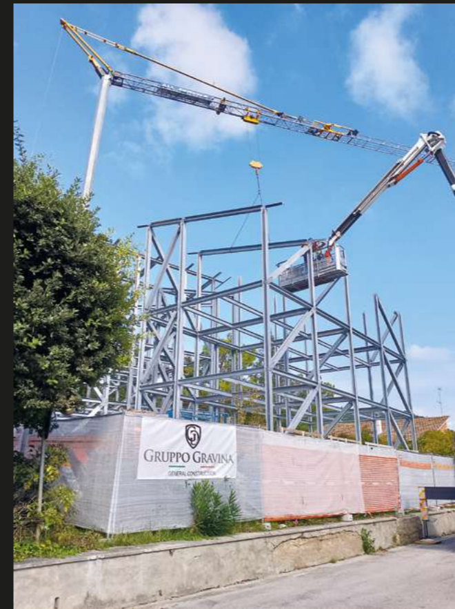
Strutture in acciaio
