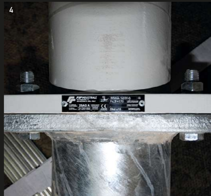
1. Isolatori sismico posizionamento, 2. Beton plaquè, 3. Rinforzi in FRP su travi, 4. Controventi dissipativi - Particolare
