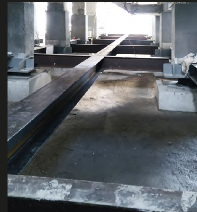
Isolatore sismico Posizionamento
