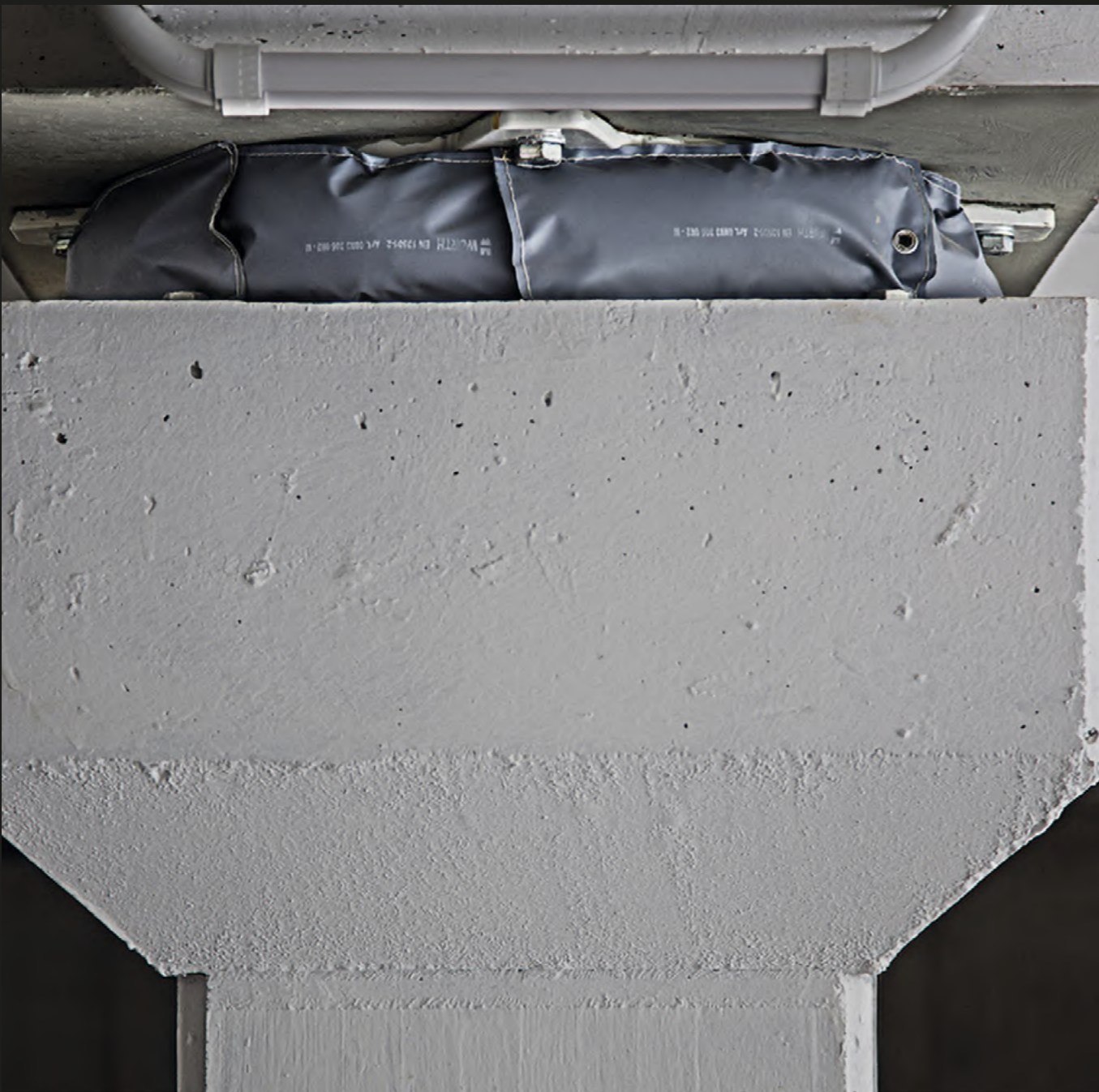
Isolatore sismico - Particolare
